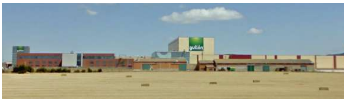
Figura 165. Usos industriales. Instalaciones de Gullón en el Polígono Industrial Laguna Salada
