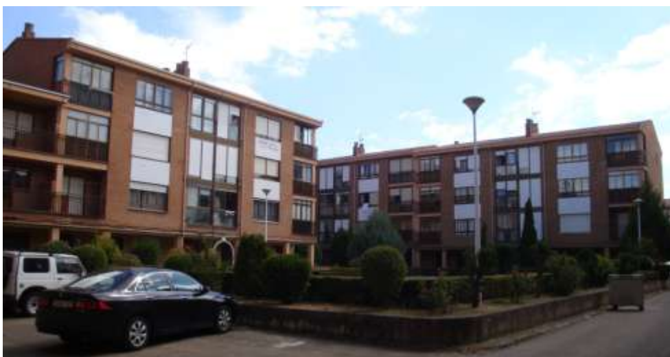
Figura 164. Vivienda residencial colectiva en la Setura
