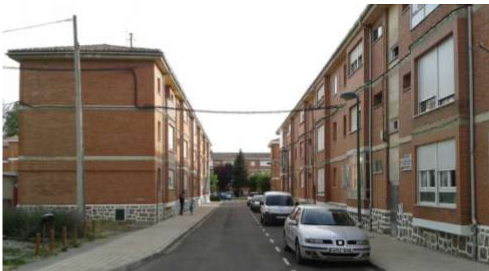
Figura 153. Vivienda plurifamiliar en Marqués de Aguilar
