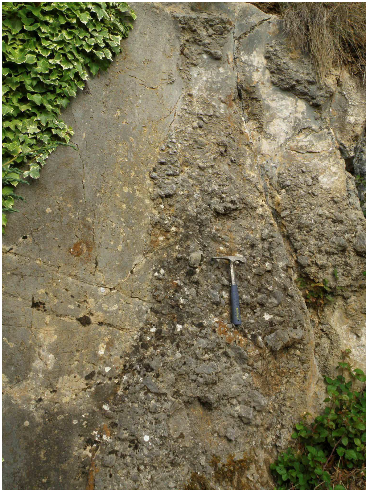
Fotografía 34004-TEC-005-5: Detalle de la brecha de falla
