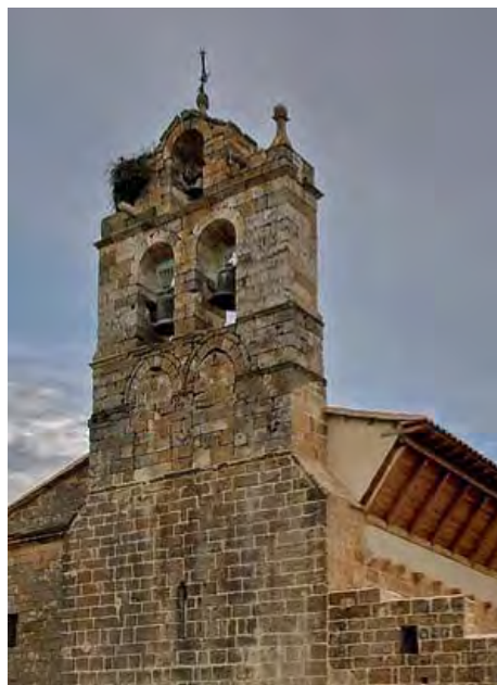
Vista aérea y detalle del campanario de la Iglesia de San Andrés (Barrio de San Pedro)
