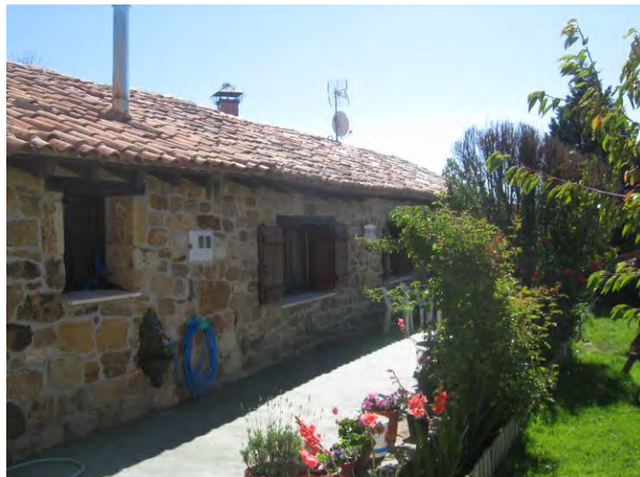
Vista de las construcciones de Quintanillina, actualmente arregladas.
