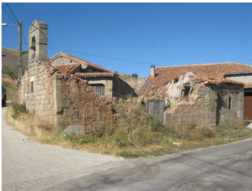
Estado actual de la Iglesia de Grijera
