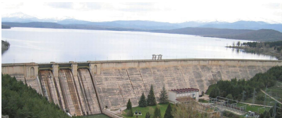
Figura 9. Presa de Aguilar.
